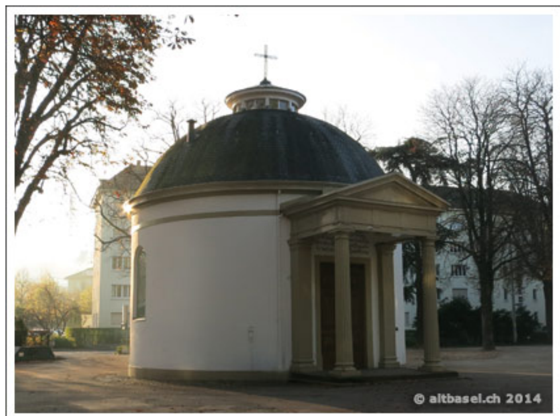
Die von Melchior Berri entworfene ehemalige Abdankungskapelle des 1833 eröffneten Rosentalgottesackers (heute Rosentalanlage).
