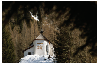
Die Stalenkapelle oberhalb von Reckingen
